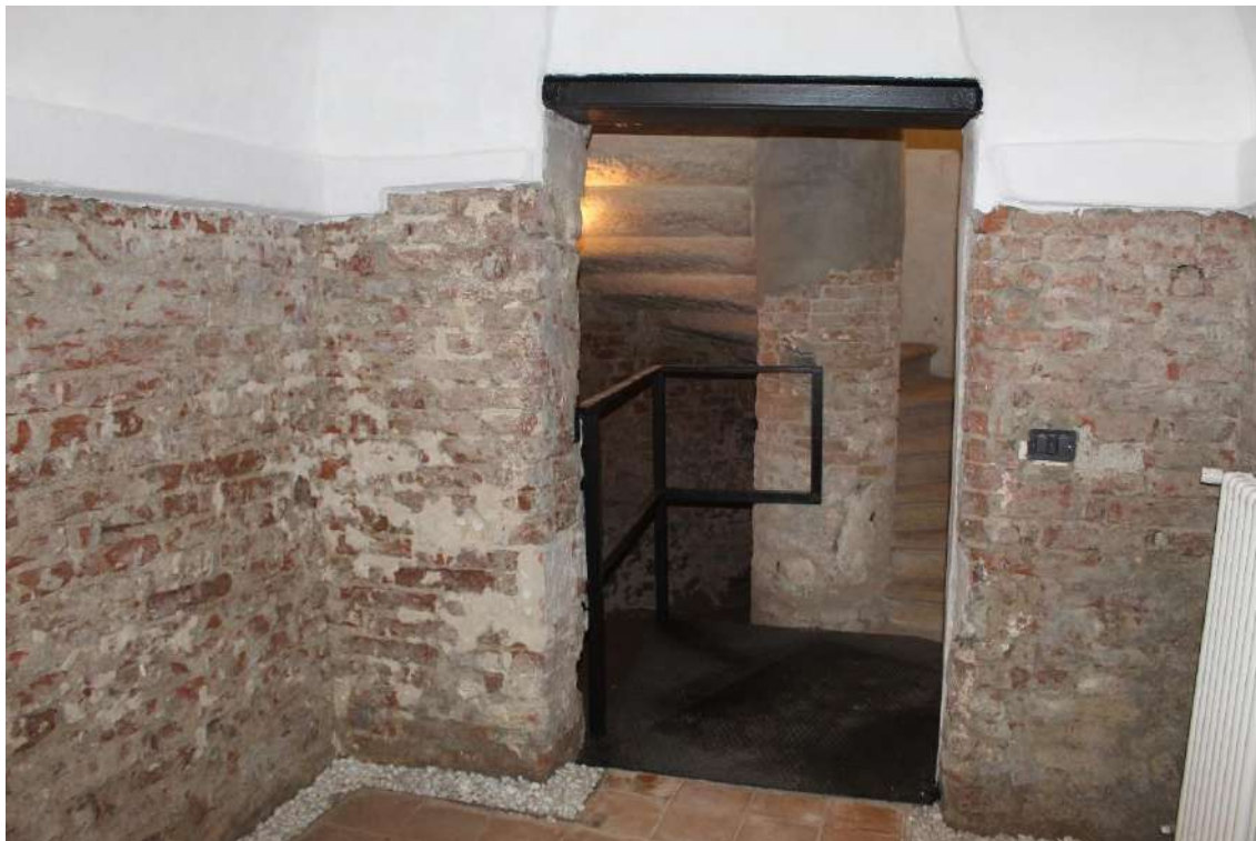
Figura 19 – Livello 0.00 – Umidità da risalita, Assenza di intonaco e parziali giunti disgregati
