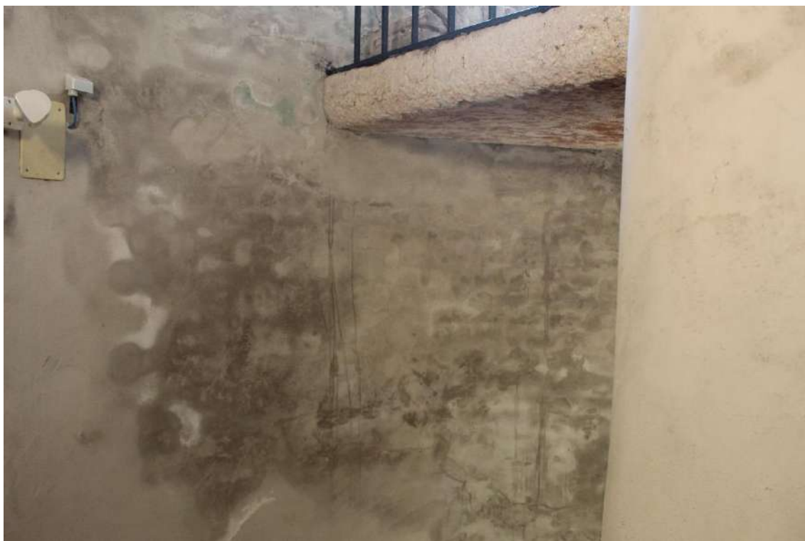
Figura 24 – Livello 20.70 - Vecchie infiltrazioni provenienti dalla pavimentazione della copertura
