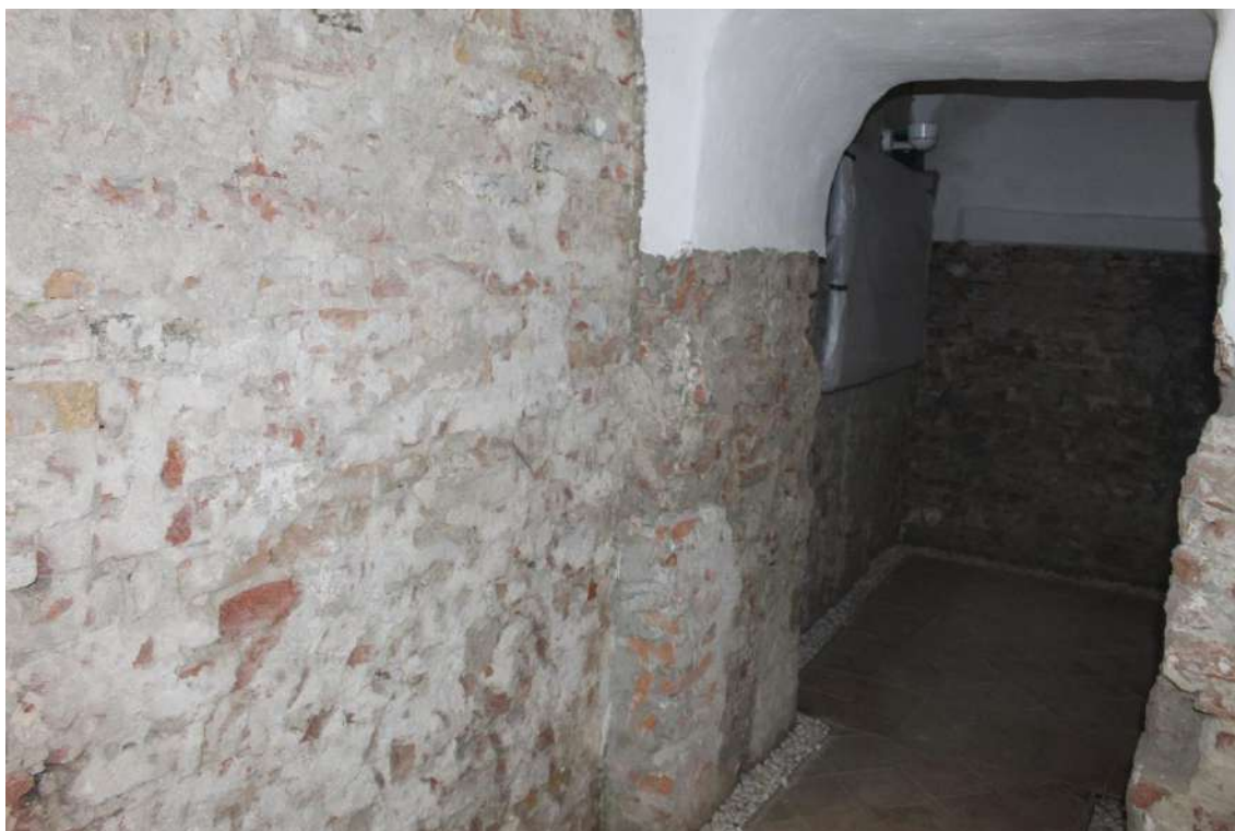
Figura 16 – Livello 0.00 – Assenza di intonaco e parziali giunti disgregati
