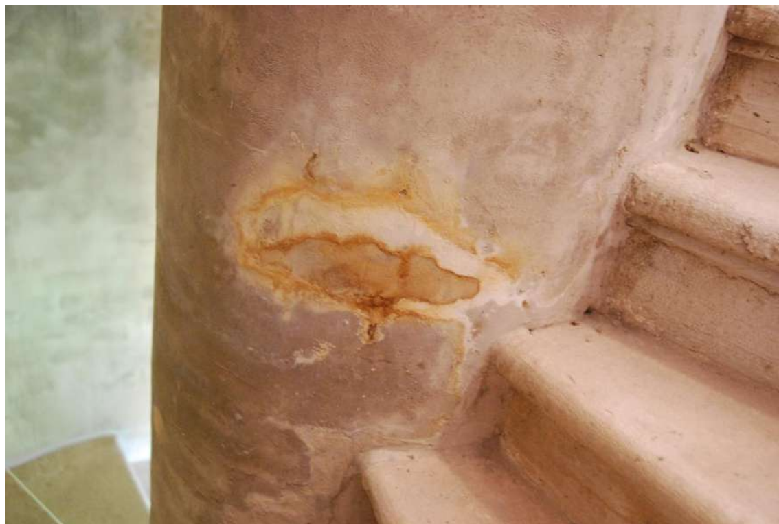
Figura 26 – Pilastro della scala - Macchie di ruggine ed efflorescenze dell'intonaco
