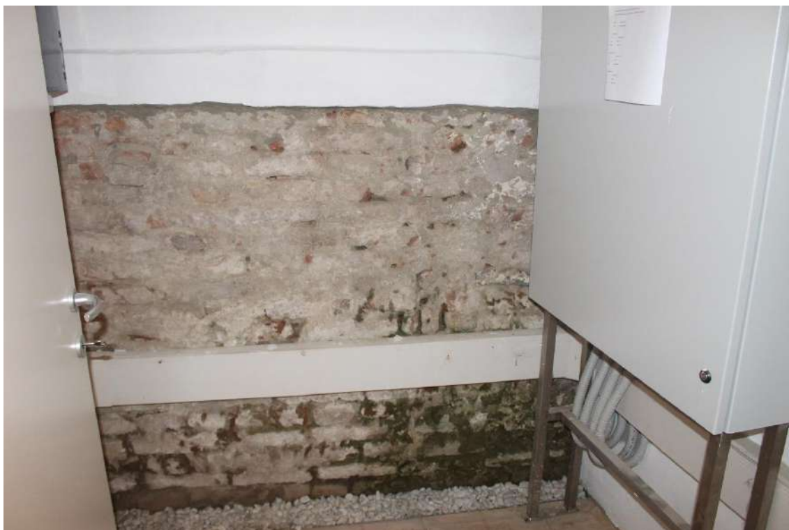
Figura 15 – Livello 0.00 – Efflorescenze derivanti da umidità di risalita
