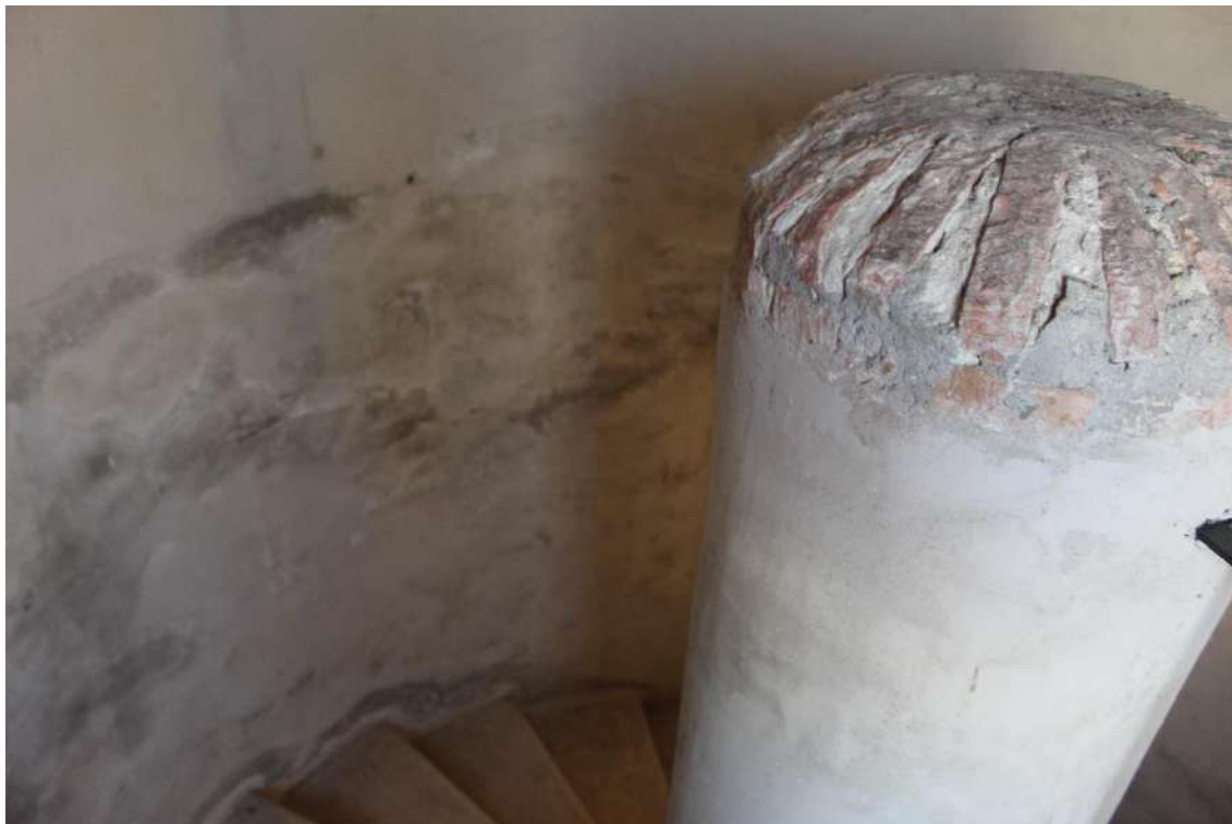
Figura 23 – Livello 20.70 - Vecchie infiltrazioni provenienti dalla pavimentazione della copertura
