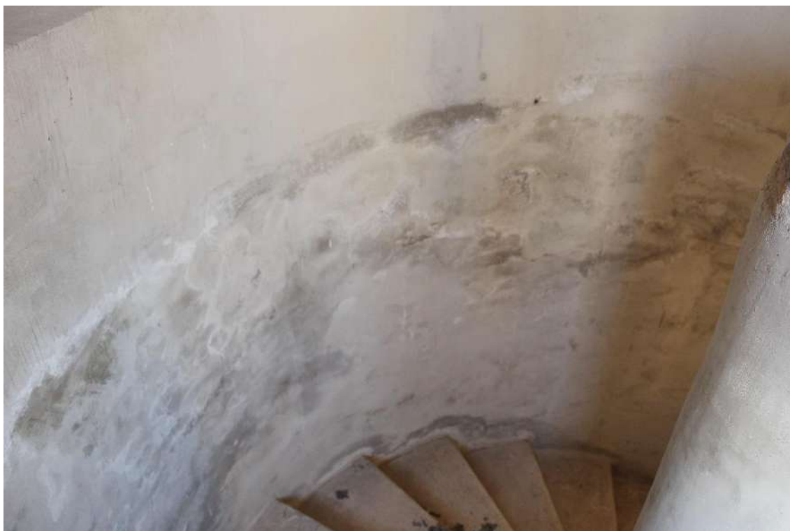
Figura 22 – Livello 20.70 - Vecchie infiltrazioni provenienti dalla pavimentazione della copertura
