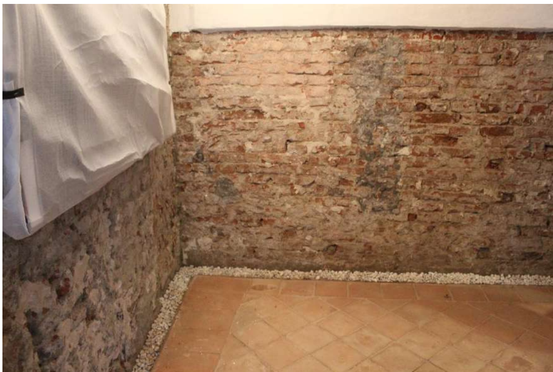
Figura 18 – Livello 0.00 – Assenza di intonaco e parziali giunti disgregati
