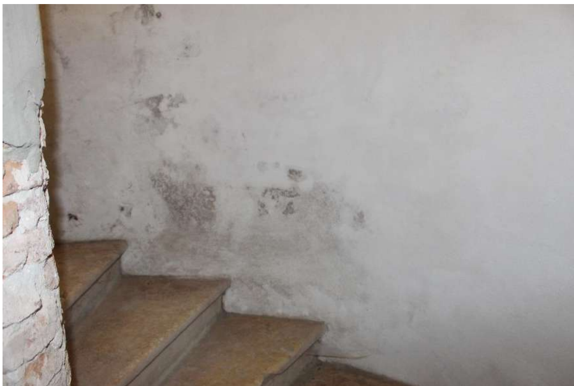
Figura 20 – Tra livello 0.00 e livello 3.15 – Umidità di risalita nel vano scala
