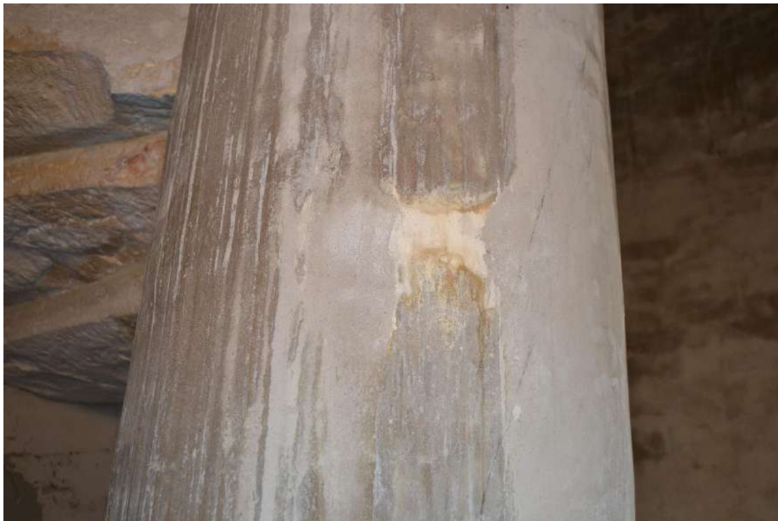
Figura 29 – Pilastro della scala - Colature delle resine utilizzate per il fissaggio delle barre di rinforzo dei gradini
