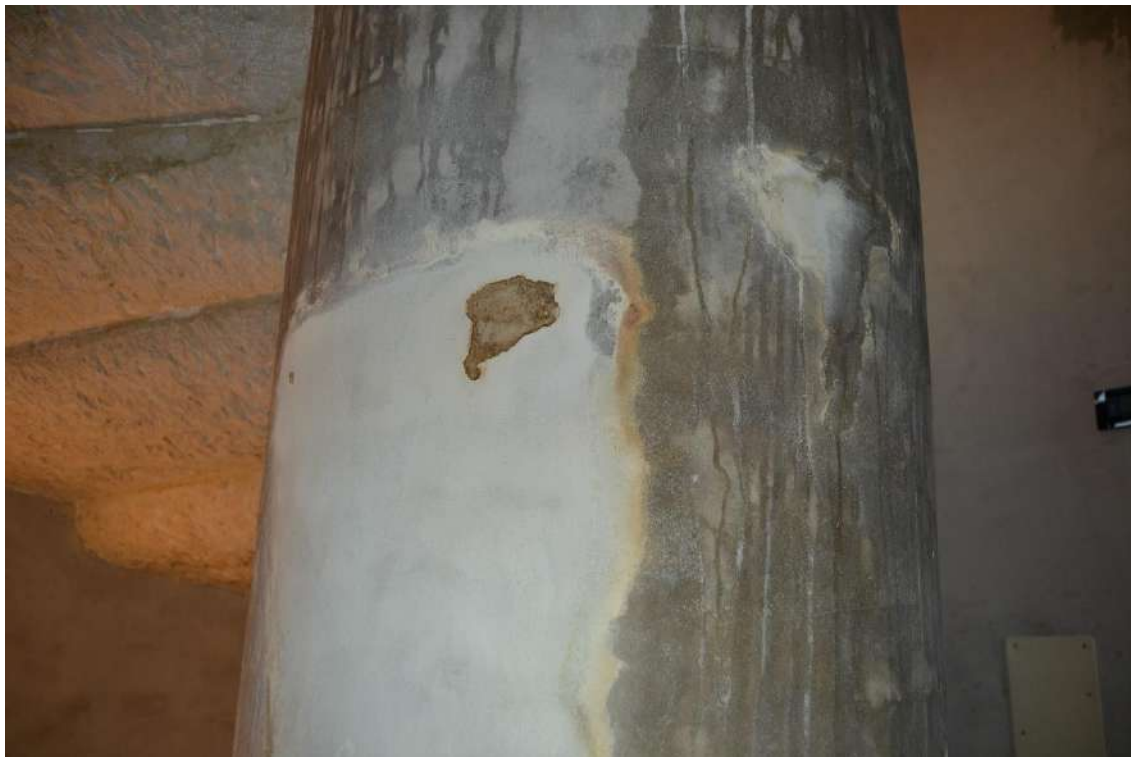
Figura 27 – Pilastro della scala - Macchie di ruggine ed efflorescenze dell'intonaco
