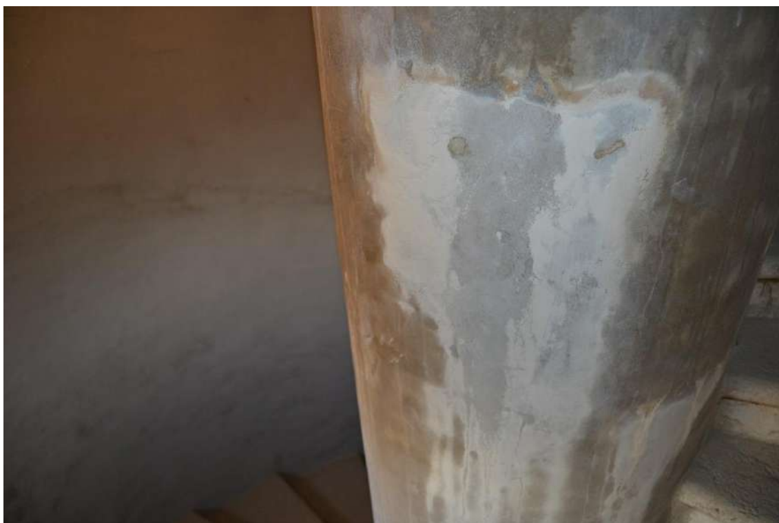
Figura 28 – Pilastro della scala - Colature delle resine utilizzate per il fissaggio delle barre di rinforzo dei gradini
