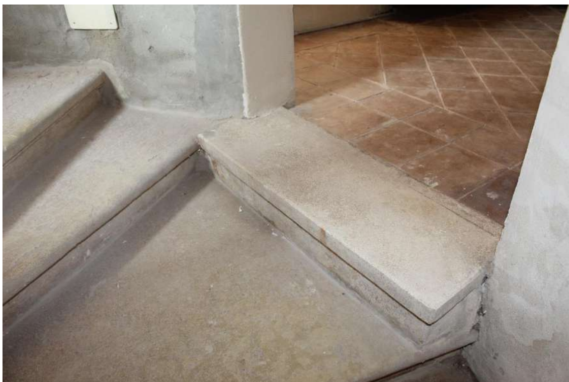
Figura 30 – Livello 3.15 - Soglia in graniglia di cemento in corrispondenza della porta di accesso alla scala
