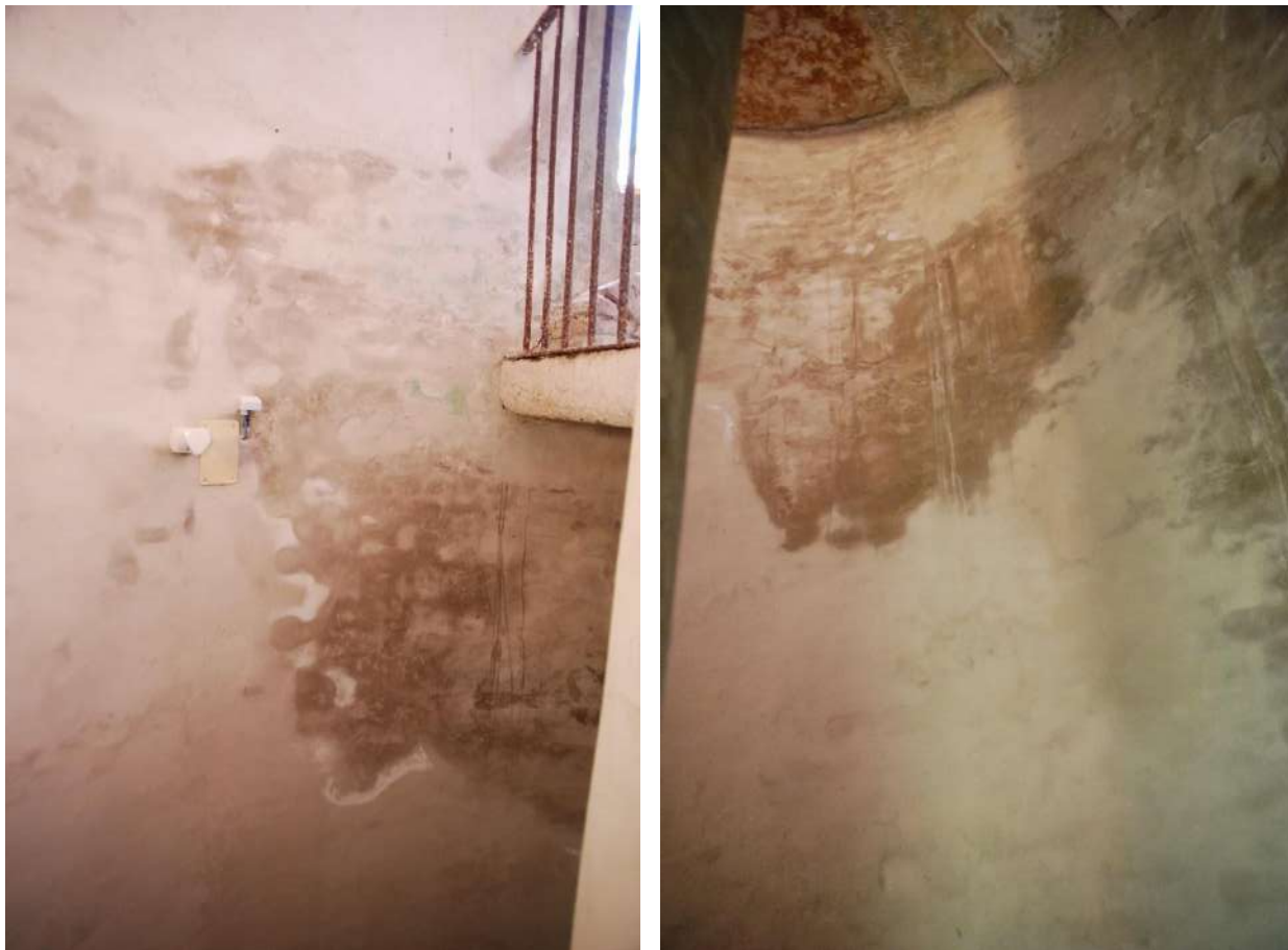
Figura 25 – Livello 20.70 - Vecchie infiltrazioni provenienti dalla pavimentazione della copertura
