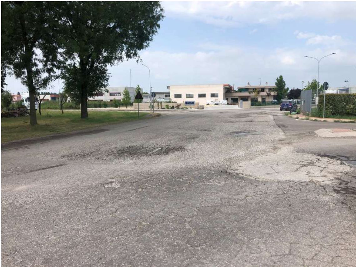
Figura 13 -Via dell'Artigianato: particolare degli avvallamenti della sede stradale
