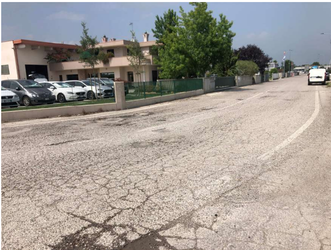
Figura 22 -Via dell'Artigianato: particolare degli avvallamenti della sede stradale
