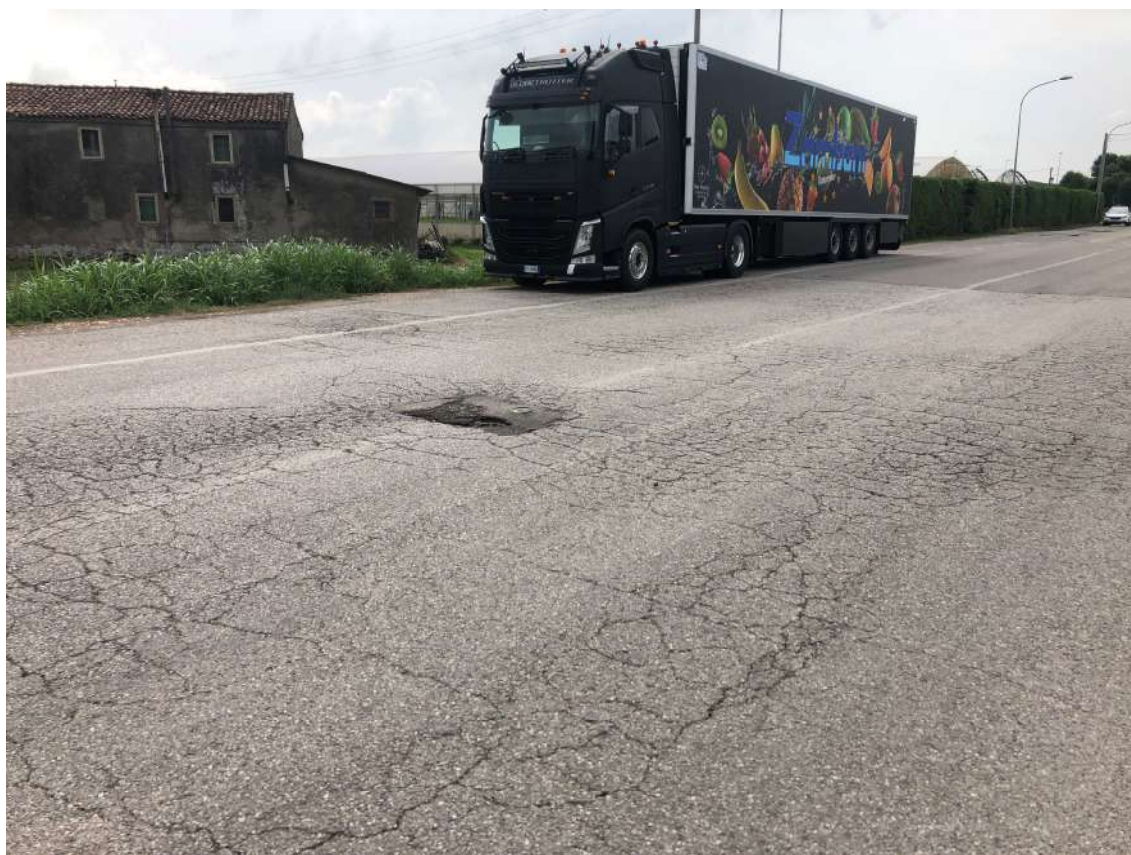
Figura 8 -Via dell'Artigianato: particolare degli avvallamenti della sede stradale in corrispondenza dei sottoservizi esistenti
