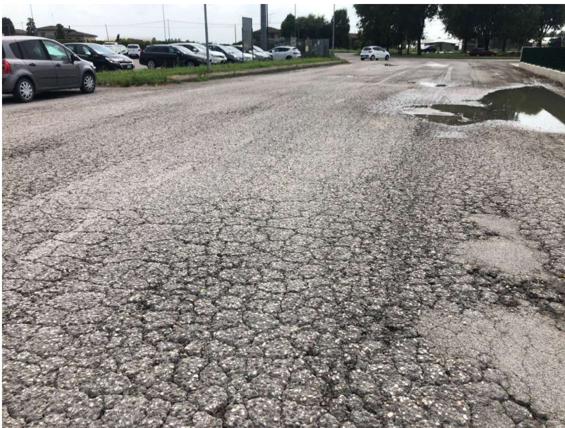
Figura 21 -Via dell'Artigianato: particolare degli avvallamenti della sede stradale
