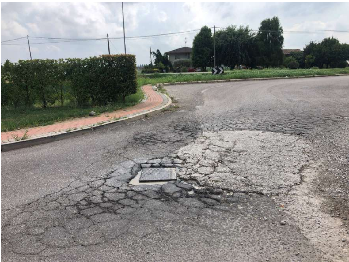
Figura 14 -Via dell'Artigianato: particolare degli avvallamenti della sede stradale in corrispondenza dei sottoservizi esistenti
