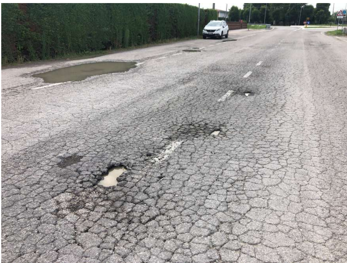
Figura 4 -Via dell'Artigianato: particolare degli avvallamenti della sede stradale
