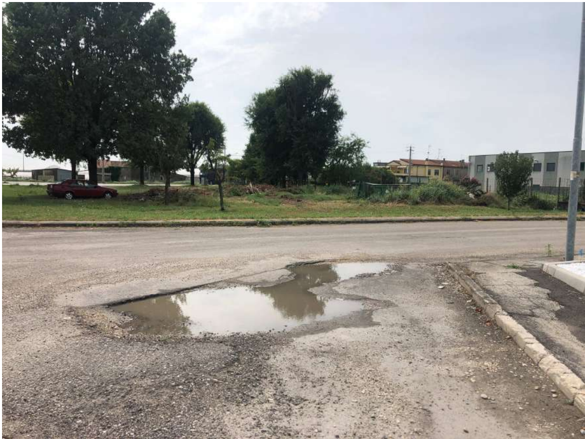
Figura 17 -Via dell'Artigianato: particolare degli avvallamenti della sede stradale in corrispondenza dell'ingresso di un'attività commerciale
