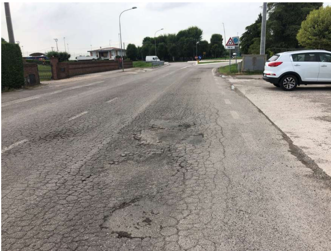
Figura 3 -Via dell'Artigianato: particolare degli avvallamenti della sede stradale
