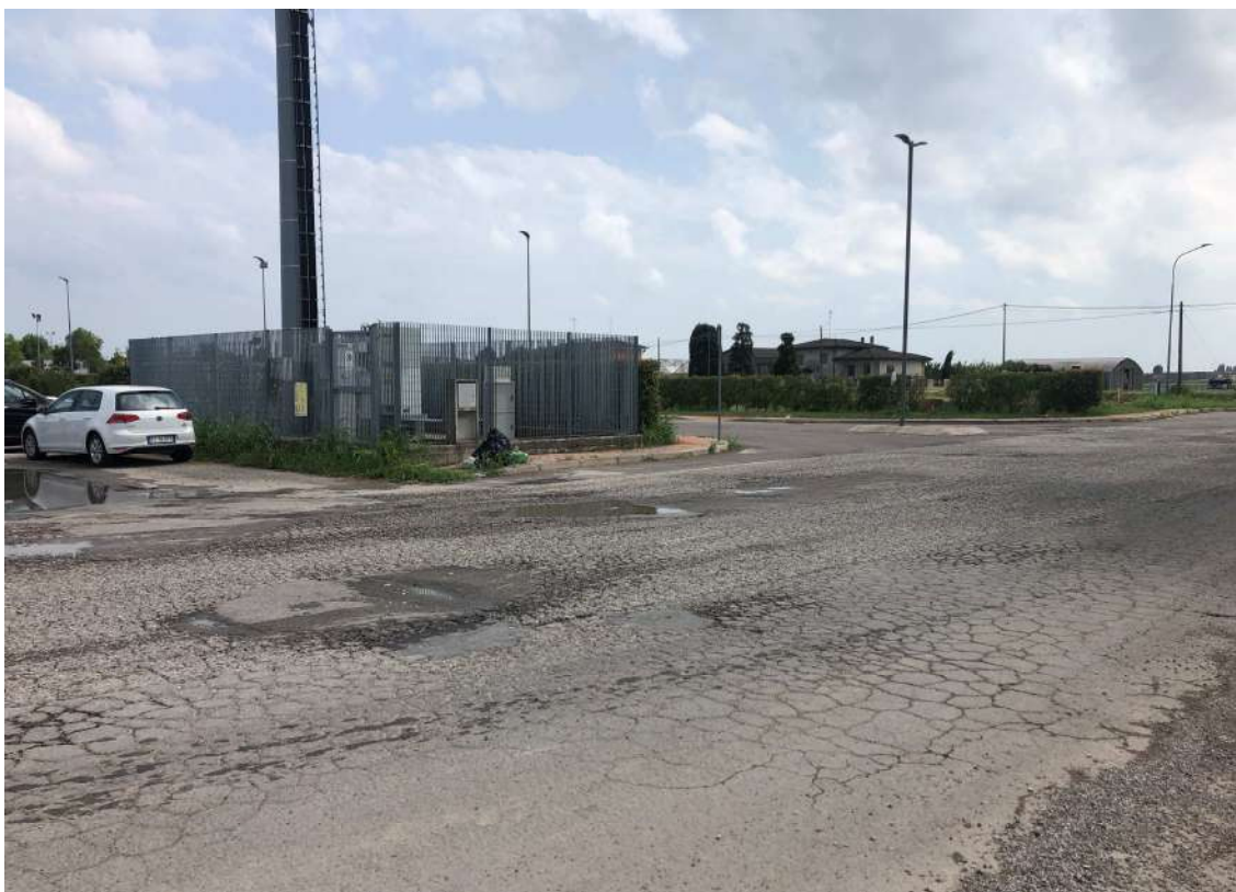
Figura 15 -Via dell'Artigianato in prossimità dell'ingresso del parcheggio: particolare degli avvallamenti della sede stradale in corrispondenza dei sottoservizi esistenti
