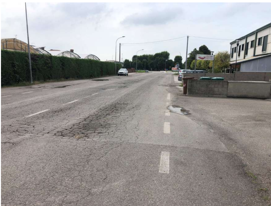
Figura 6 -Via dell'Artigianato: particolare degli avvallamenti della sede stradale
