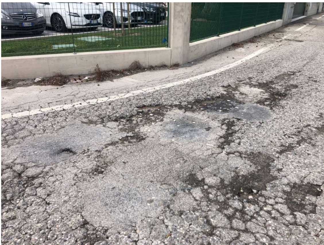
Figura 23 -Via dell'Artigianato: particolare degli avvallamenti della sede stradale
