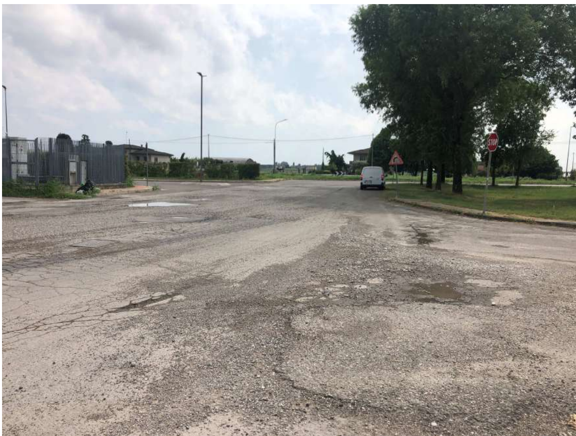
Figura 16 -Via dell'Artigianato: particolare degli avvallamenti della sede stradale in corrispondenza dei sottoservizi esistenti
