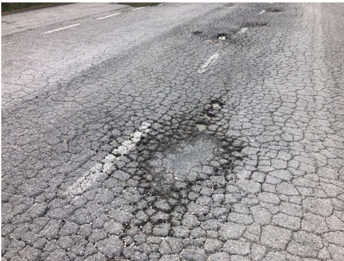
Figura 5 -Via dell'Artigianato: particolare degli avvallamenti della sede stradale
