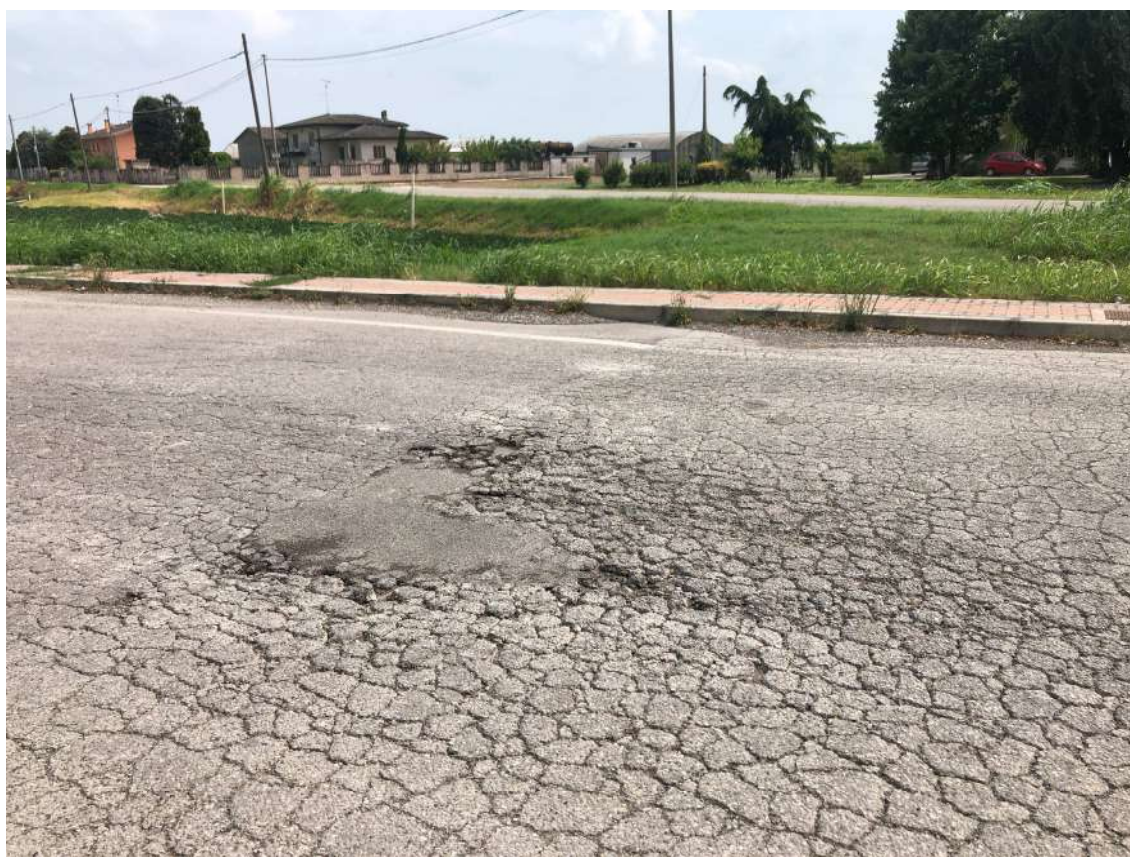
Figura 10 -Via dell'Artigianato: particolare degli avvallamenti della sede stradale in corrispondenza dei sottoservizi esistenti
